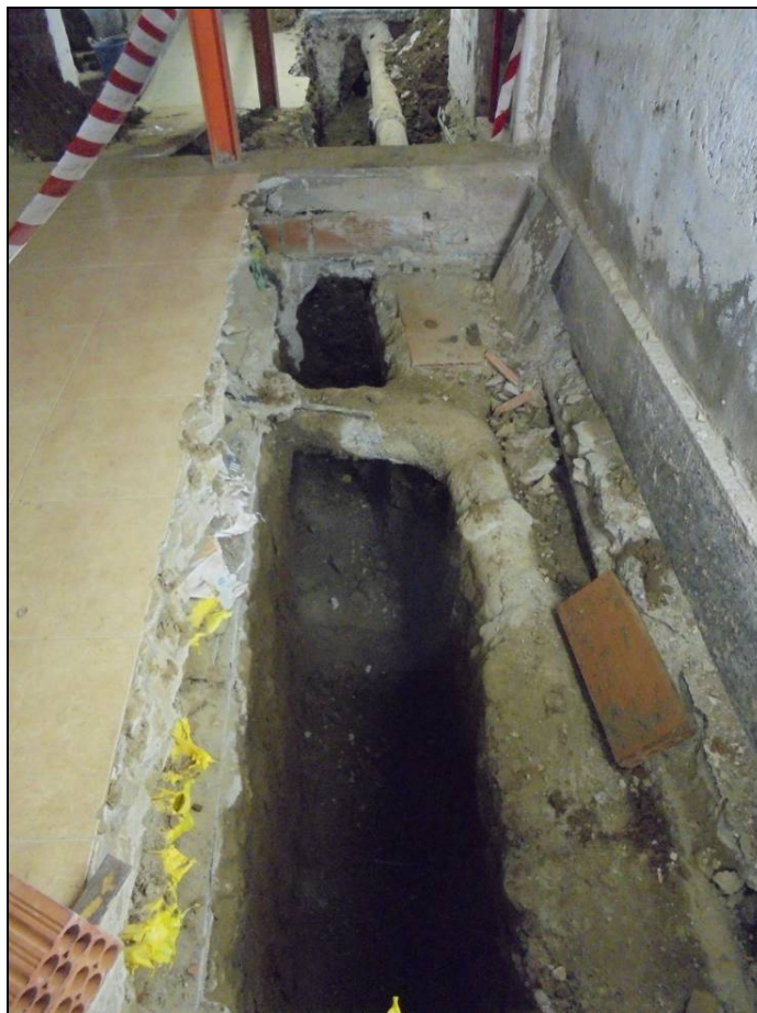
Fotografia 19: Rasa en el Sector 3, i segon tram del Sector 2 al fons.
