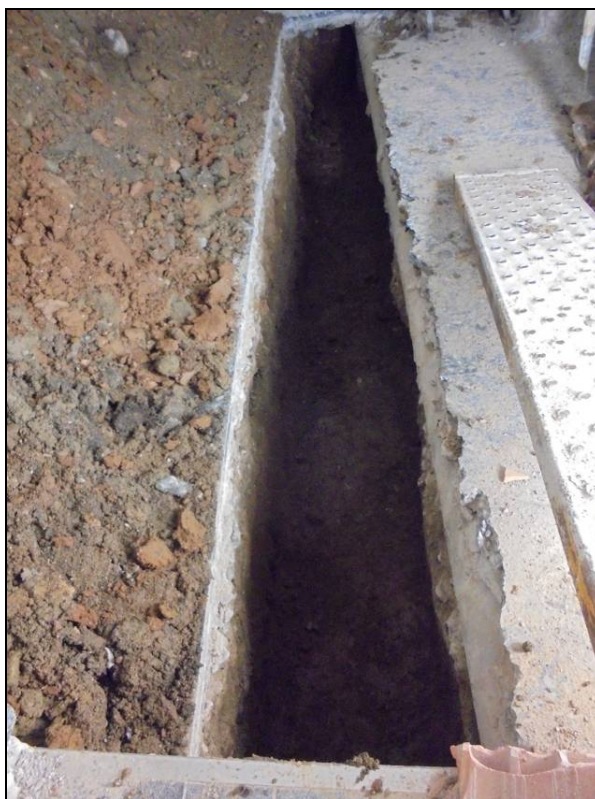
Fotografia 8: Rasa del primer tram del Sector 2.
