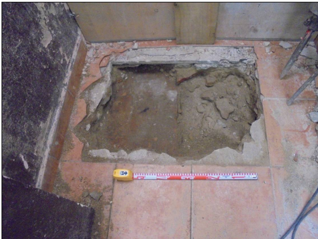
Fotografia 3: Inici treballs de l'arqueta de l'entrada.
