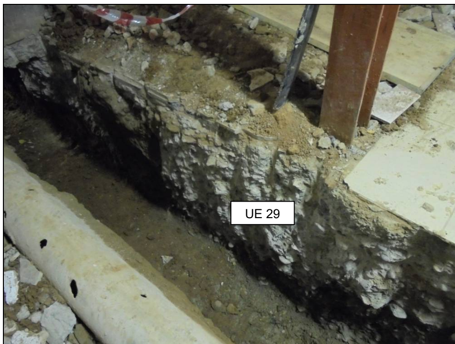
Fotografia 13: Fonamentació de formigó de les bigues de reforç del sostre.
